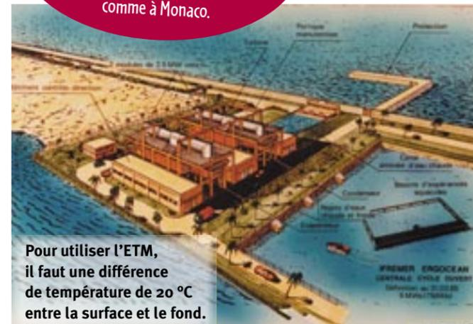
Pour utiliser l'ETM, il faut une différence de température de 20 °C entre la surface et le fond.
